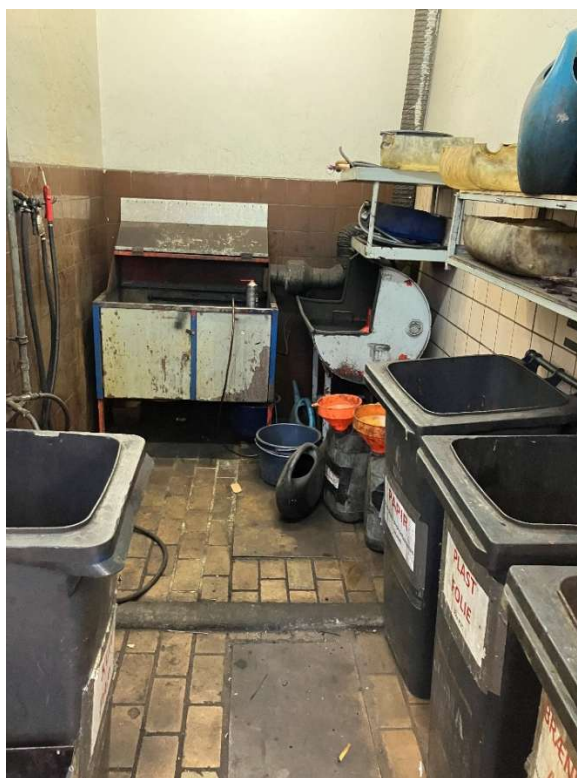
Figur 1: "Motorrum". I dag anvendes rummet til opbevaring af affald. Afløbet i rummet skal afproppes, så der ikke er mulighed for at aflede vand fra dette rum.
