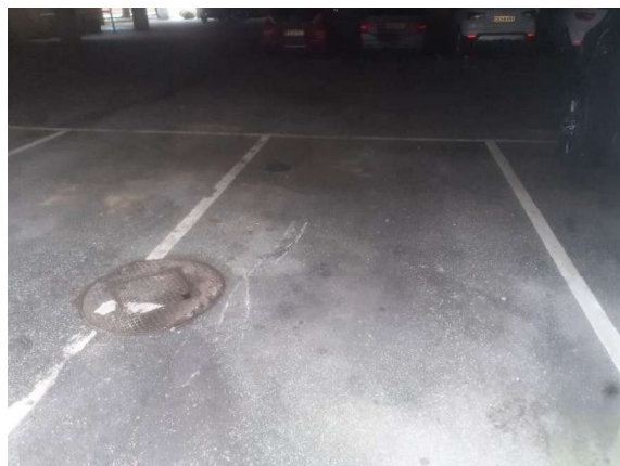
#6 Boring B4 udført øst for tank R2 under parkeringsdæk, set fra vest.
