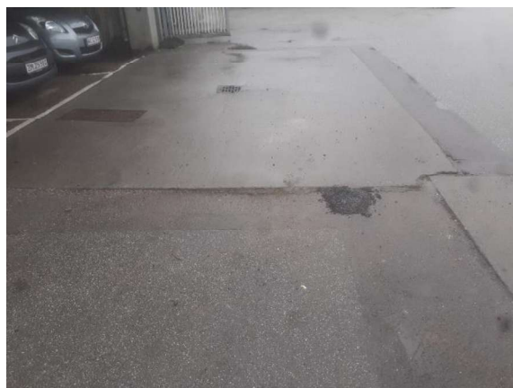
#4 Boring B2 udført sydvest for tank R1 og nord for påfyldningsplads., set fra nord.
