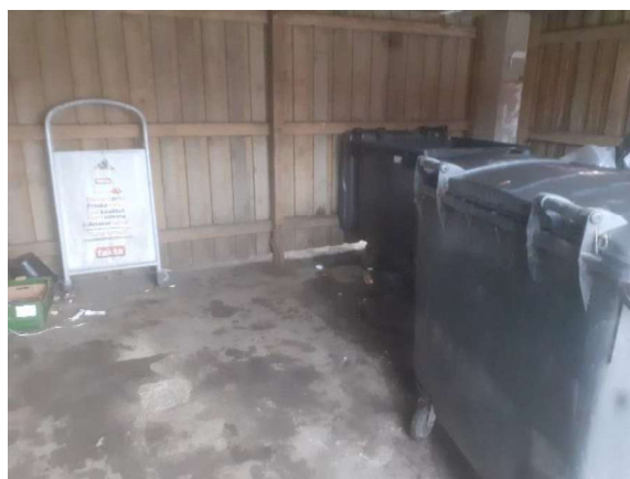
#8 Boring B5 udført i affaldsskur ved olieudskiller, set fra vest.
