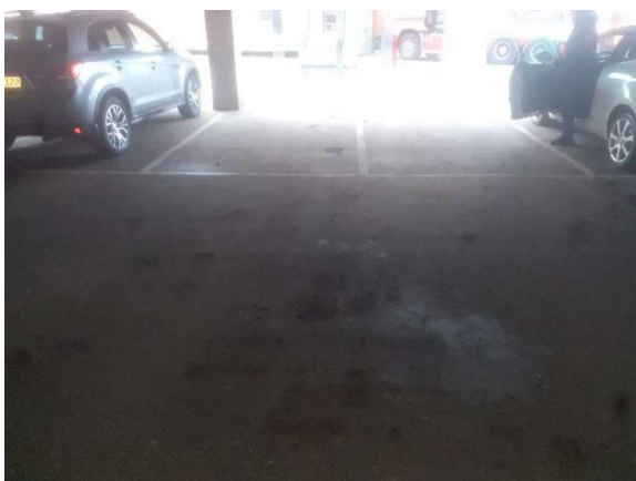
#7 Boring B6 og B4 udført øst for tank R2 under parkeringsdæk, set fra øst.
