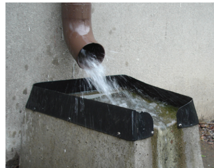
Figur 1: (Forsidebillede): Afkoblet nedløbsrør i bebyggelsen Augustenborg i Malmø. Foto Orbicon.
