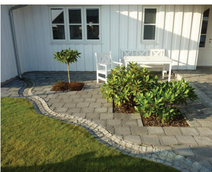
Figur 26: Regnvand ledes i en tæt rende bort fra huset til nedsivning i græsplænen. Foto Orbicon, Trekroner i Roskilde.
