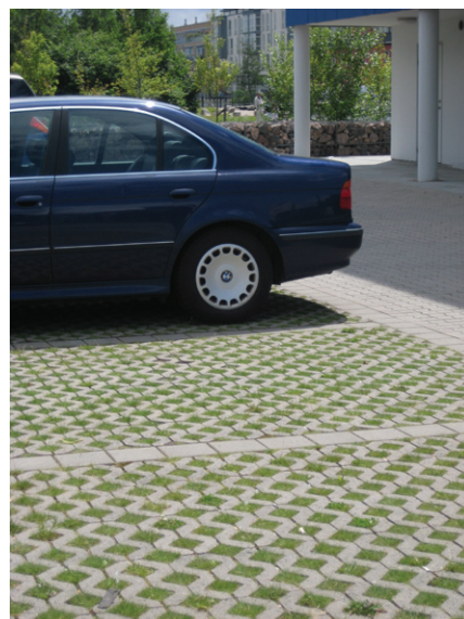
Figur 35: Permeabel græsarmering på parkeringsplads i boligområdet B001 i Malmø Västra Hamn. Græsarmering sikrer både nedsivning og fordampning af regnvand. Foto Orbicon
