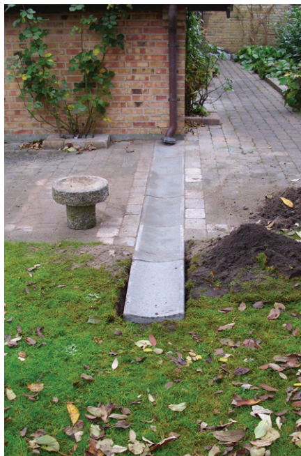
Figur 22: Eksempel på rende til at lede regnvand fra nedløbsrør og ud på græsplænen.
