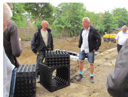
Figur 17: Faskinekassetter ved anlægsarbejde i Valby. Foto Orbicon
