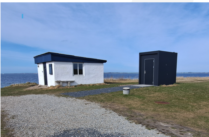
Fig. 1: Indsendt foto. Toiletbygningen ses til højre.
