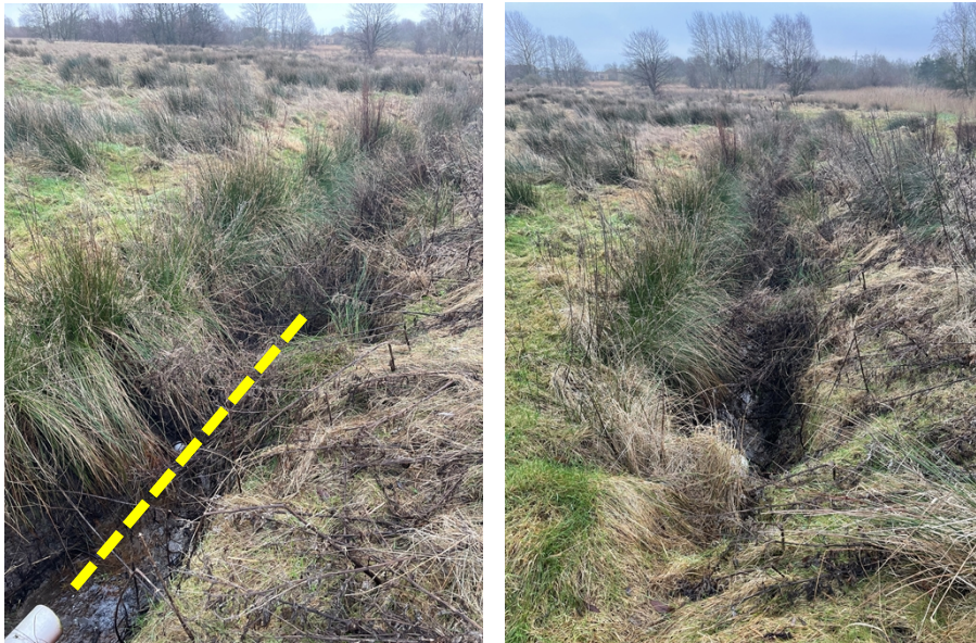
Figur 3. Foto af Tilløb til Øster Afvandingskanal omkring Rolstrupvej 13. Rørudløb fra Rolstrupvej ses på foto til venstre (13. januar 2025). Gul stiplede linje: Rørlægningen forlænges på strækningen ca. 8,5m.
