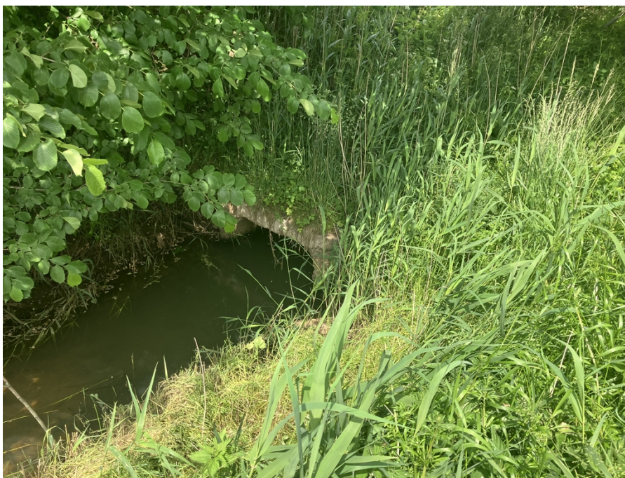
Figur 4. Foto af Øster Afvandingskanals eksisterende rørunderløb under Elsøvej (4. juni 2025).
