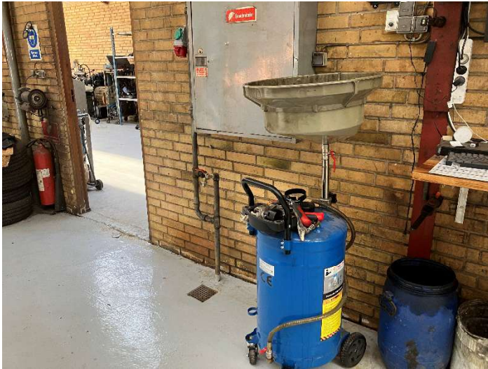
Foto 1: Gulv afløb i værksted
