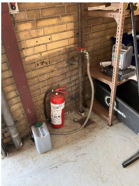
Foto 3: Gulv afløb i værksted. Nær port
