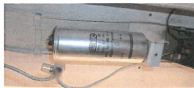
Figur 2. Kondensator i el-armatur, hvorfra der kan lækkes PCB.
