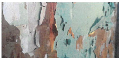
Figur 1. Væg med PCB-holdige malinglag.
