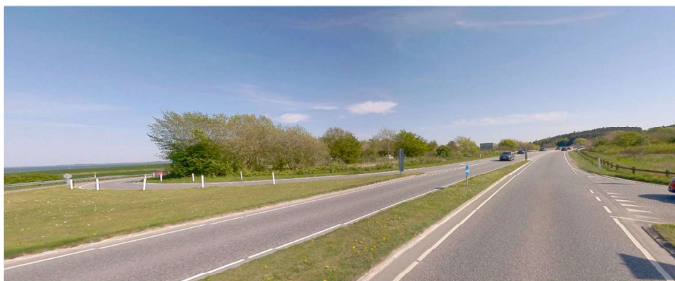
Figur 5-3 Kig til samkørselspladsen fra Sallingsundvej, østgående retning. (Standpunkt 2).
